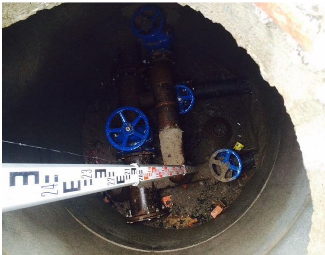
41 - сурет – Су құбыры құдықтарындағы мониторингтік нүктелер
