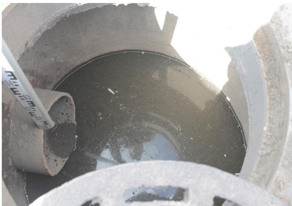
42 - сурет – Канализациялық құдықтардағы мониторингтік нүктелер
