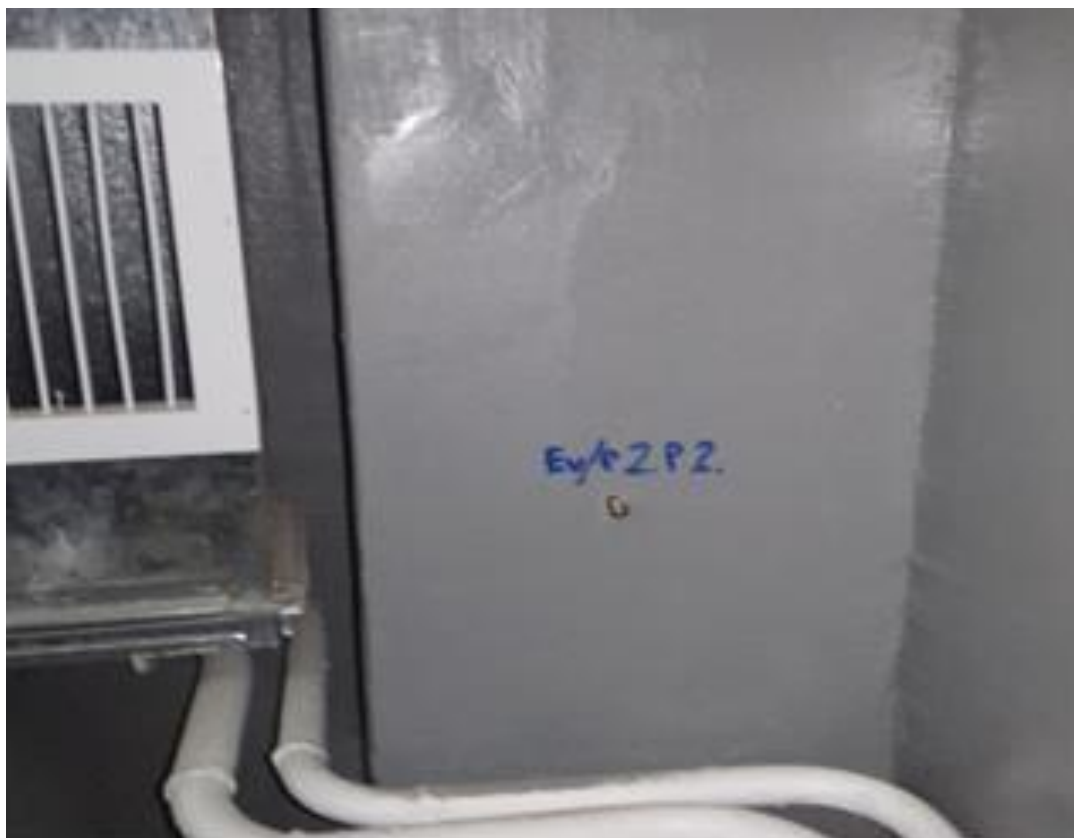
38 - сурет – Ғимараттың және паркингтердің, жертөле бағандарындағы мониторингтік нивелирлік нүктелер
