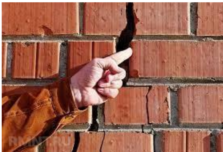
19- сурет – Инженерлік құрылыстар деформациялануының әсерінен пайда болған жарықшақтар
