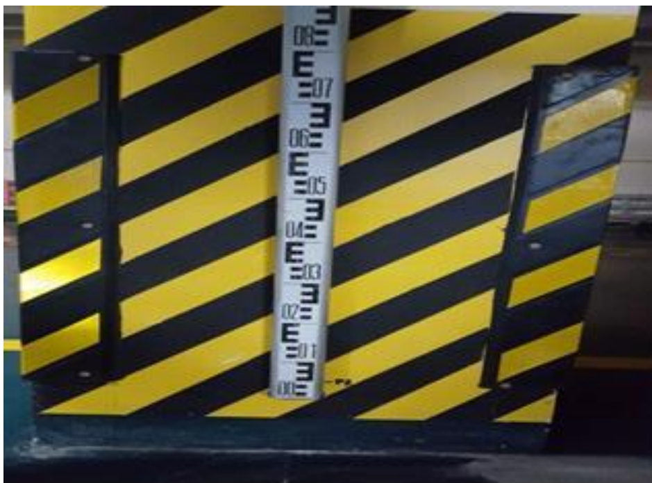
37 - сурет – Ғимараттың және паркингтердің, жөртөле бағандарындағы мониторингтік нивелирлік нүктелер
