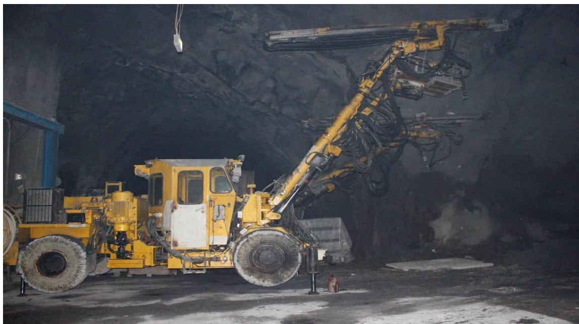
8 - сурет – Atlas Copco Rocket Boomer 352 S жабдықтарымен қорғаныс экраны құбырларын бұрғылау
